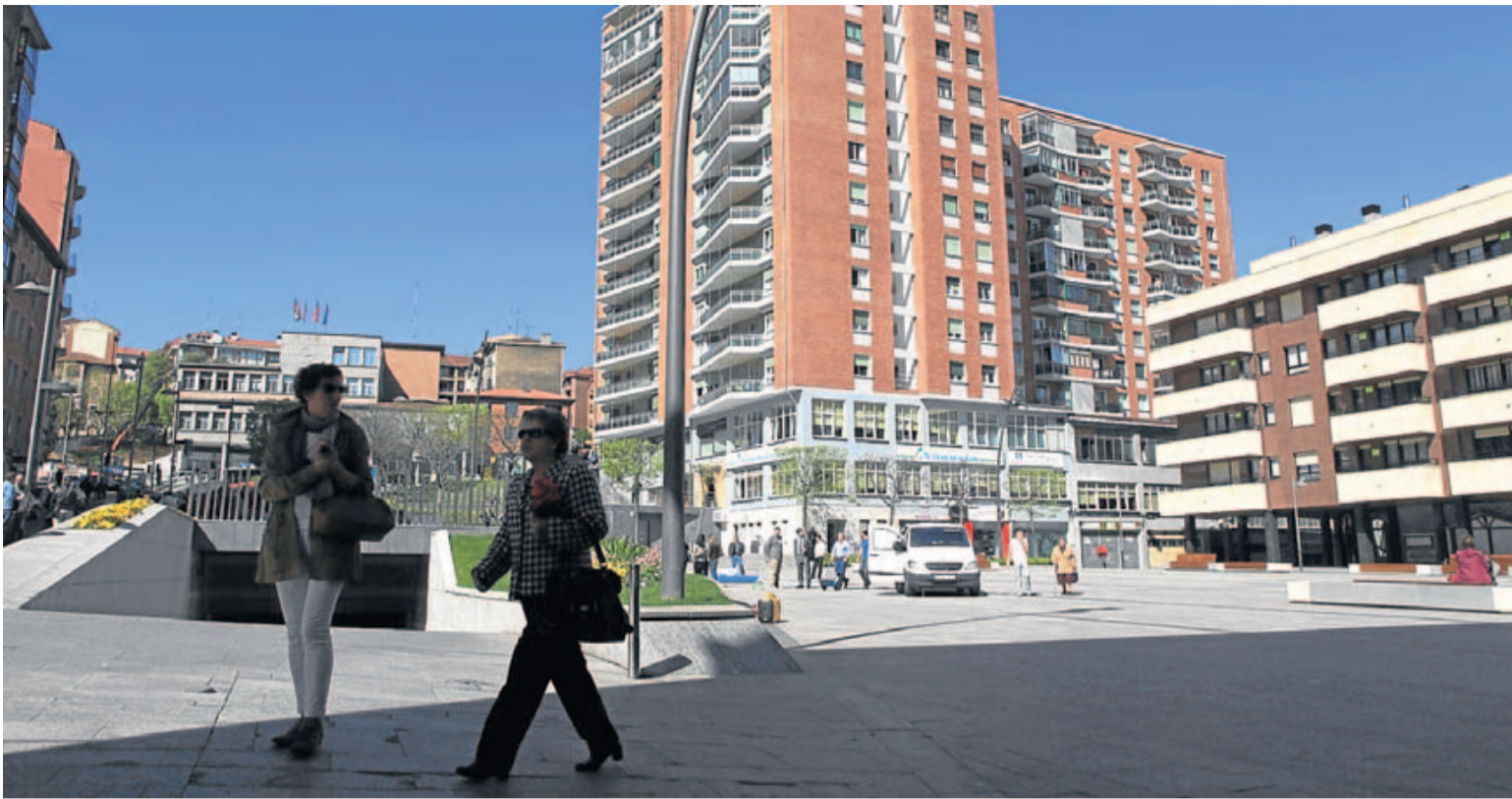
Las obras de las viviendas de Arizgoiti estuvieron más de tres años paralizadas y su reactivación fue la chispa que encendió el conflicto. :: E. C.
